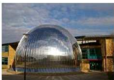
Le dôme : entrée du bâtiment K (côté campus)
